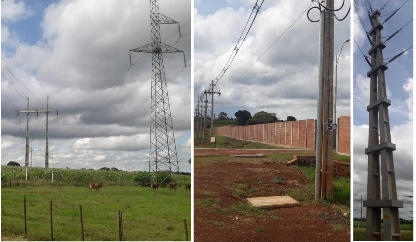
Construcción de Obras de Distribución con provisión total de materiales, Distrito de Fram, Dpto. de Itapúa - Licitación Pública Nacional ANDE N° 1200/2016 – Lotes 2 y 3 – BONOS II
